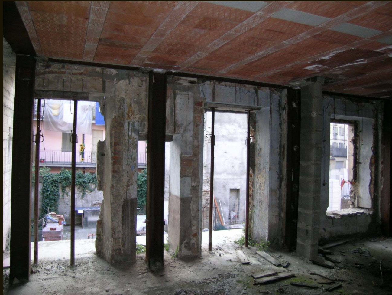
Puntellamenti strutturali provvisori per rinforzi temporanei di porzioni pericolanti
